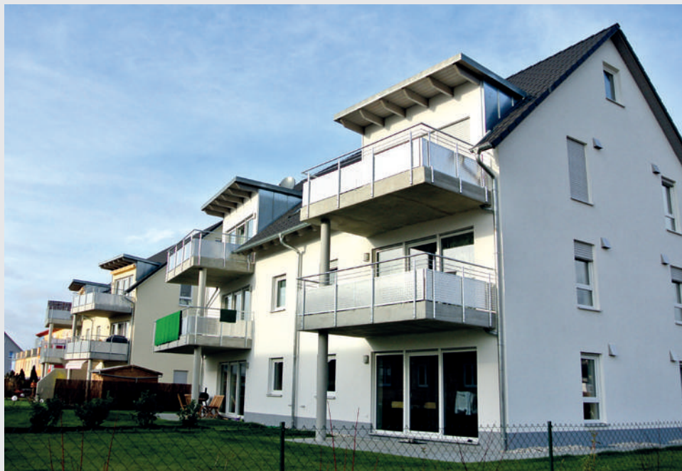
Aussiger Straße, Schwandorf: Neubau von 4 x 6 Mehrfamilienhäusern mit insgesamt 24 Wohnungen
